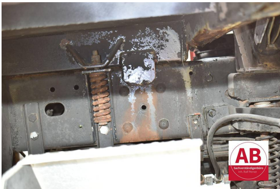
Ansicht Rahmen seitlich, Aufbau-traverse durchrostet
