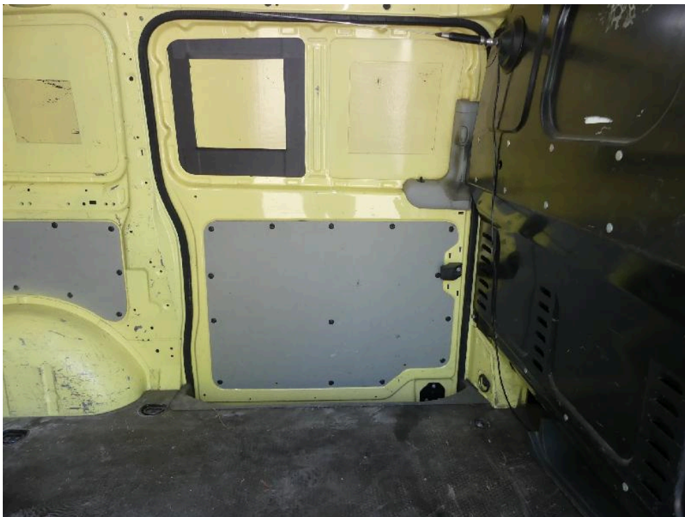
Bild: 30 Ansicht Schiebetür links im geschlossenen Zustand.
