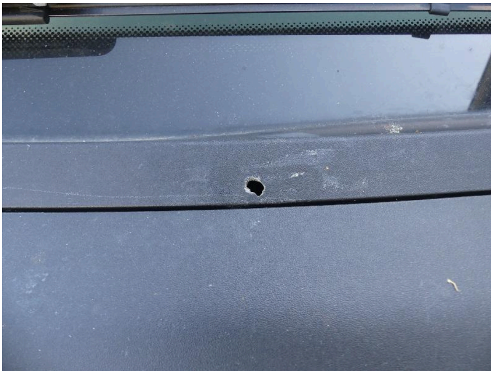
Bild: 72 ... hierbei ist ein Materialdurchbruch vorhanden.
