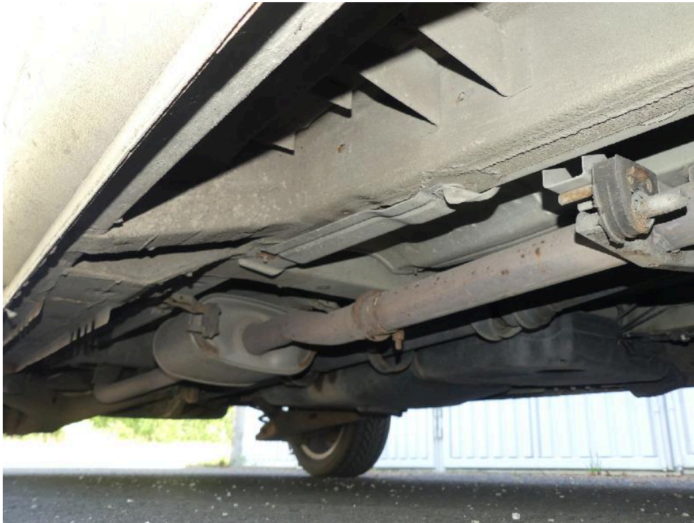
Bild: 81 Detailansicht Unterboden
