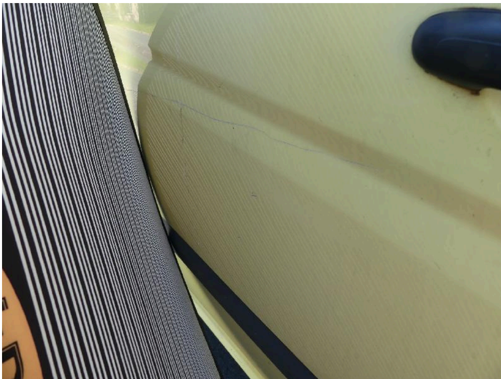
Bild: 70 Weiterführend ist die Schiebetür rechts deformiert.
