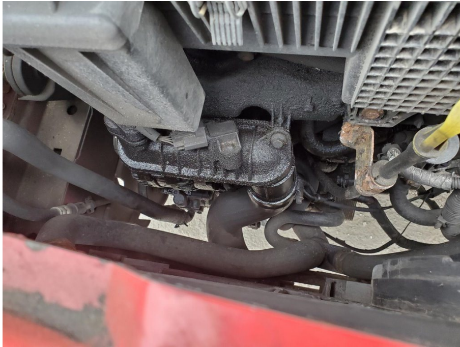
Ansicht: Ölverlust Motor
