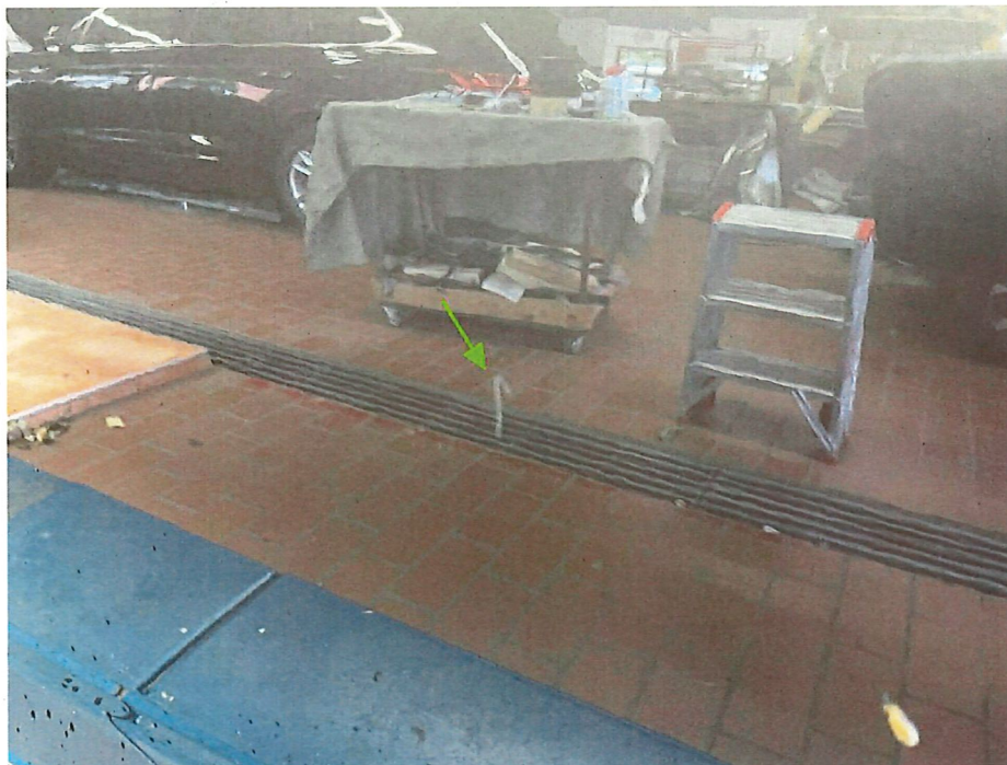
Bild 14 : Tür vorne links Lackierung, zerkratzt, lackieren mit Lackaufbau
